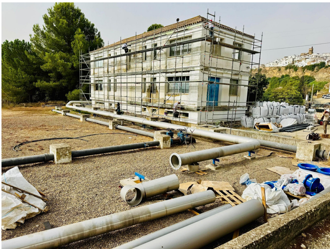
Las obras en la estación de tratamiento.
