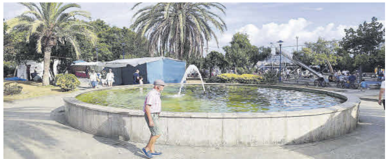
Fuente ornamental de los jardines de O Sinal, que dispone de circuito cerrado de agua. | Santos Álvarez
