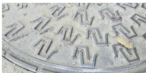
Tapa de alcantarillado sellado por Aqualia. | FdV
